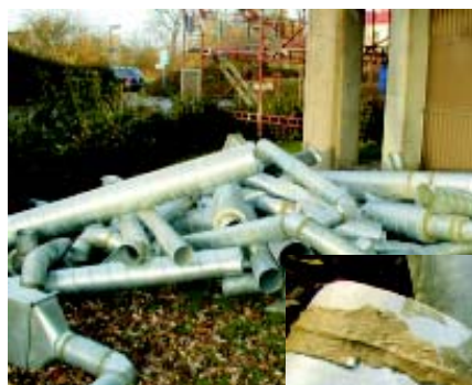
Rivning pågår vid en ombyggnad på Lasarettet i Helsingborg.
